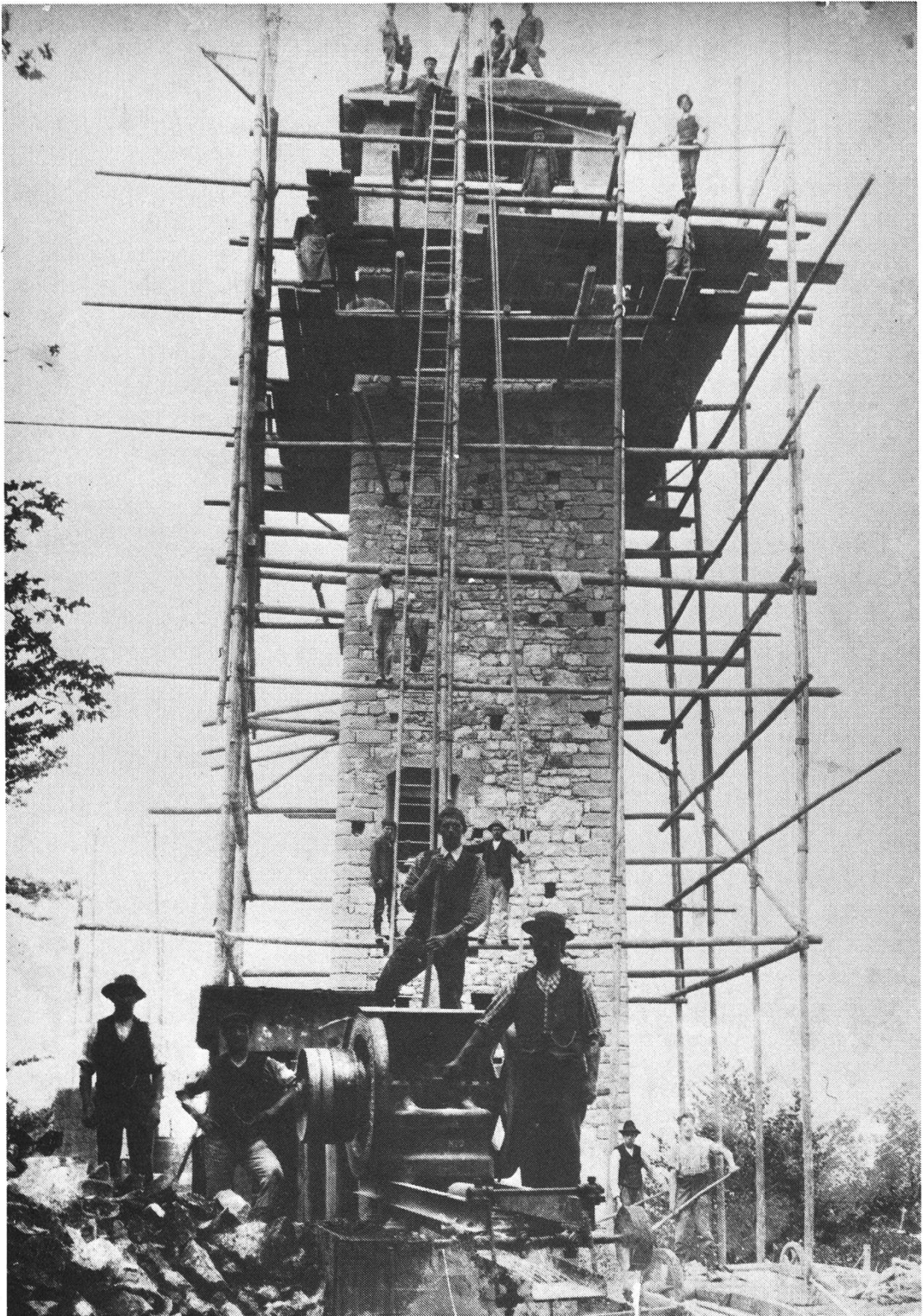
Der Sonnenbergturm ist gebaut. Jetzt wird er verputzt (1912).
