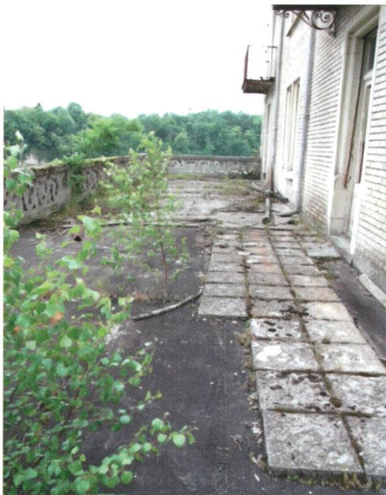
Die Terrasse vor der Renovation.
