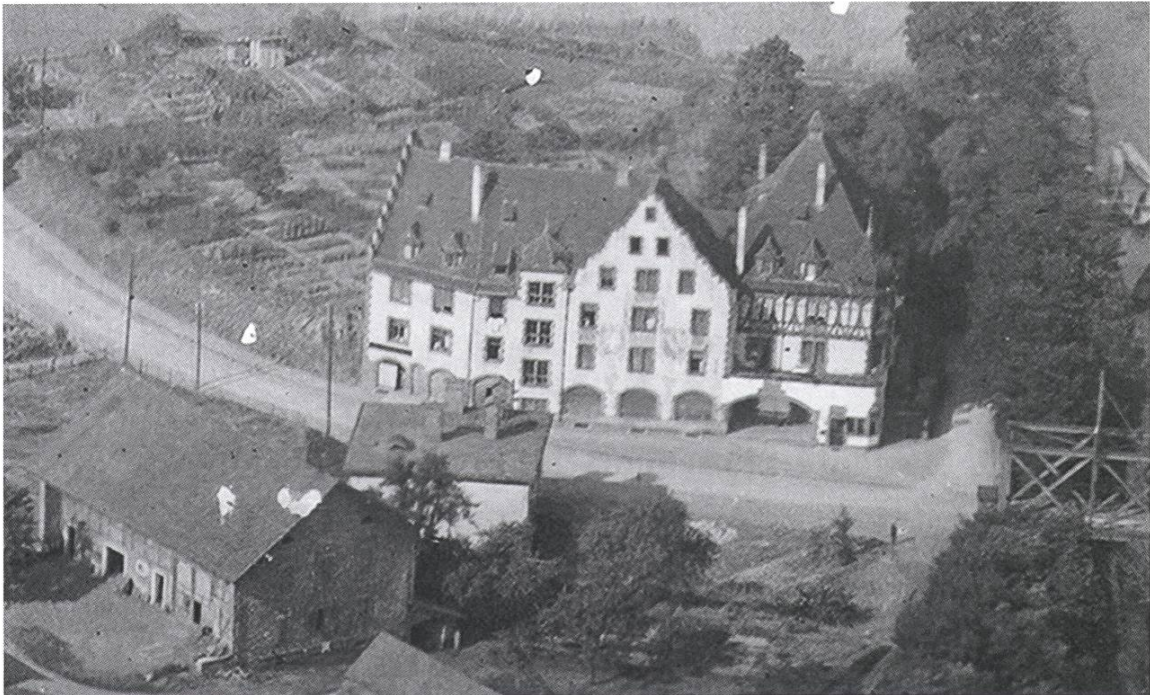
Abb. 4 Das Herzstück in der Rheinlust: a) Unterstation Rheinfelden mit 50 Hz-Drehstrom-Transformatoren; b) links hohe Holzstangen der von Beznau zuführenden 25'000 Volt-Leitung; c) rechts Strommast auf Eisensteg mit 6800 Volt-Leitung. Vergrößerter Ausschnitt aus Abb. 1 von Walter Mittelholzer, zwischen 1918 und 1924. Quelle: ETH-Bildsammlung www.e-pics.ethz.ch .
