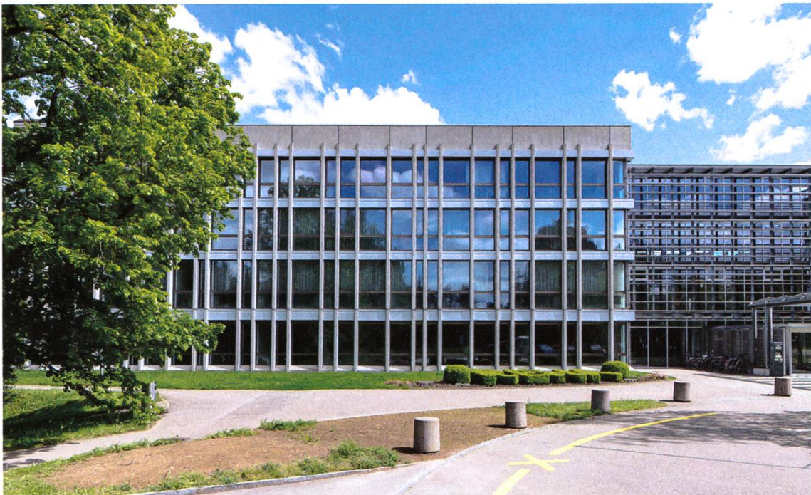
Renovation Bettenhaus Bereich 03, 2019
