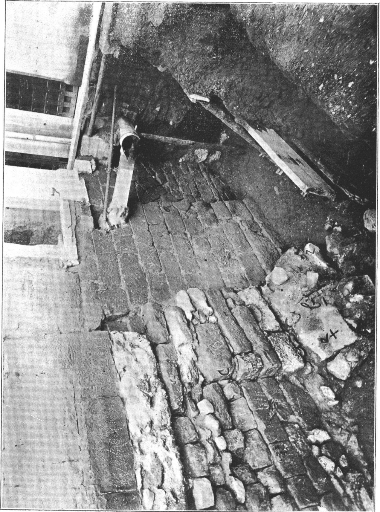
Photographie des fouilles, prise par M. Mayor, de la direction des travaux de Lausanne. Partie sud.
