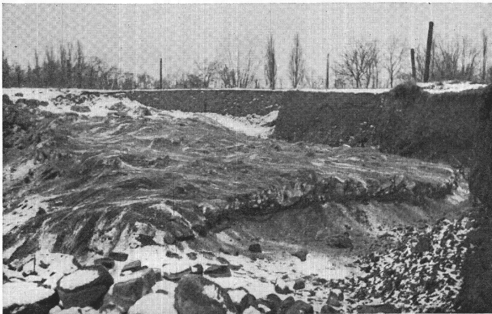
Fig. 3. — Le perré au sud-ouest de la place. Vue prise du nord (janvier 1940).
