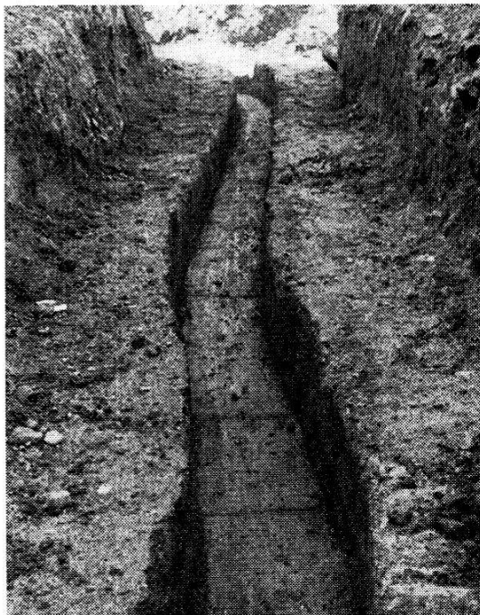
Fig. 73 Le canal pour les eaux usées. Partie visible dans la case R'' 1 .
