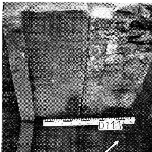
Fig. 130. — Cave A : partie ouest de l'entrée.
