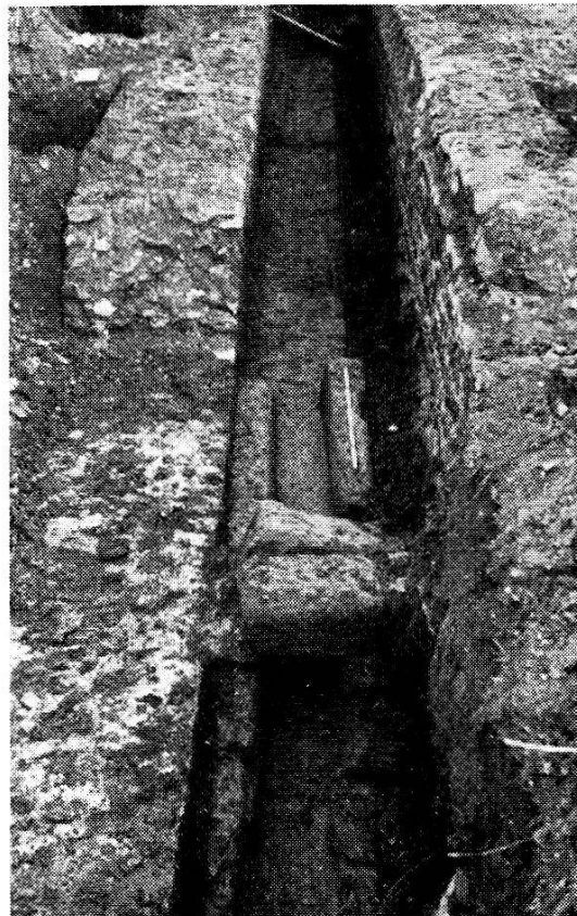
Fig. 50. — Coulisserie creusée dans des dalles de molasse logée entre les murs de la basilique et du sanctuaire (secteur 4). Vue prise du sud-ouest.
