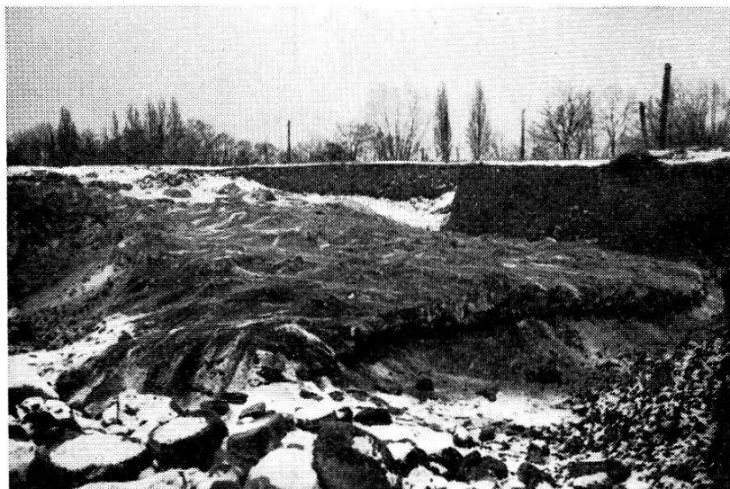
Fig. 23. — Perré de halage.
