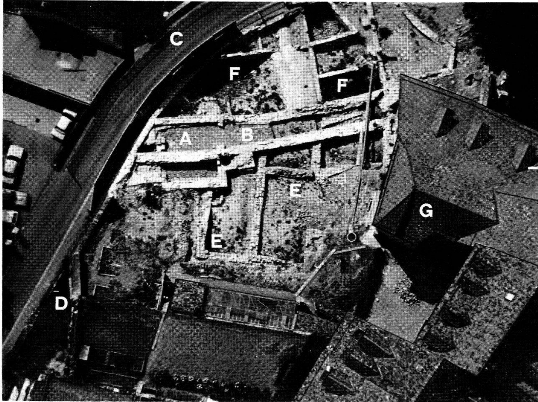
Fig. 5. Lausanne, château de Menthon. Vue aérienne du chantier, le 3.8.1979. A. Petite tour, XIV e s., coupée par un mur du XVIII e s. B. Rampe pavée, encadrée de murs de soutènement. C. Emplacement de la grande tour. D. Mur d'enceinte de la ville (XIII e s.). E. Édifice antérieur au château (XIII e s.). F. Constructions XVIII e s.- XIX e s.; cave. G. Maison Porta. Photo MHAVD.
