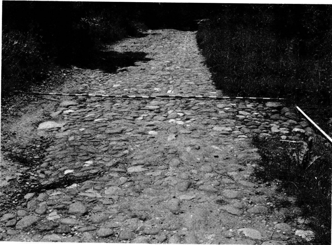
Fig. 2. Arnex. Ancienne route pavée. Vue des empièvements, de l'Est. A droite, sondage montrant la largeur complète du chemin. Photo R. Jeanneret.
