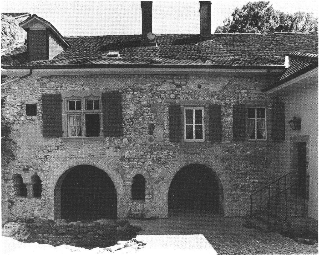
Fig. 9. Façade occidentale du bâtiment des moines en 1971 après le décrépiage.
