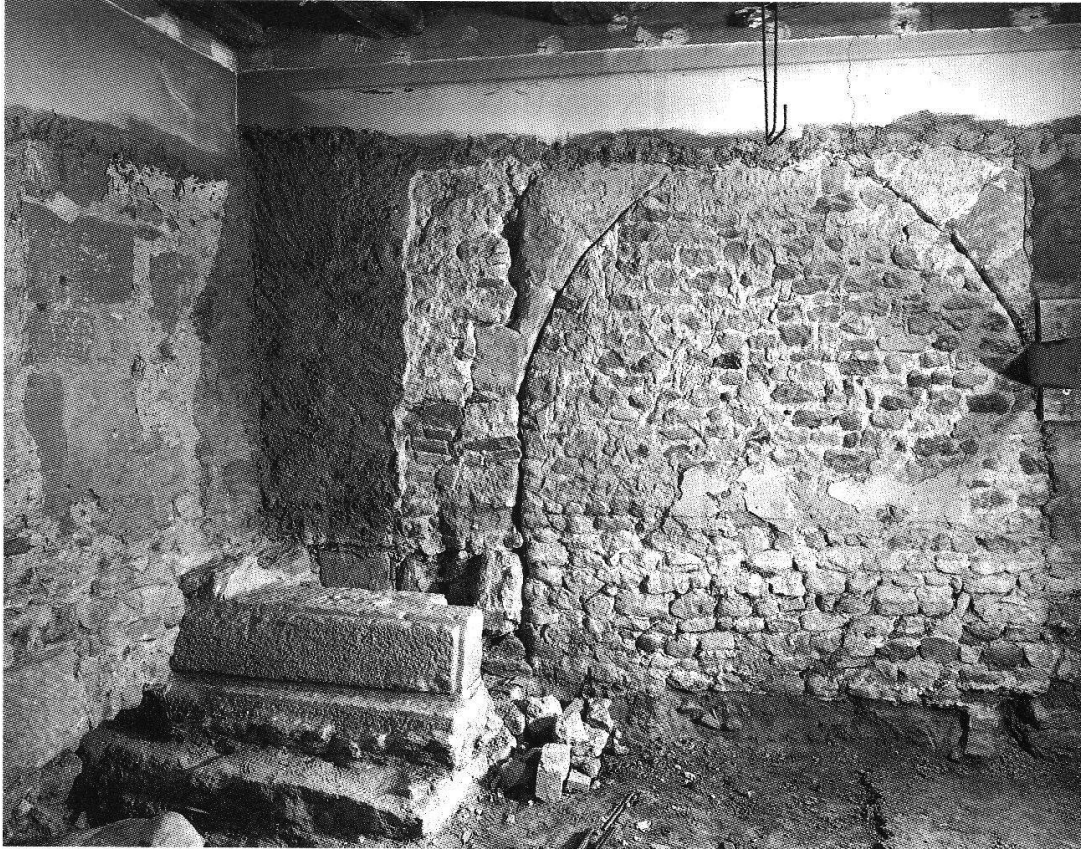
Fig. 5. AVENCHES – Rue Centrale 31. Anciennes arcades. Vue de l'arc dans un mur mitoyen, avec, à gauche, la base du pilier côté rue. (Photo R. Gindroz)
