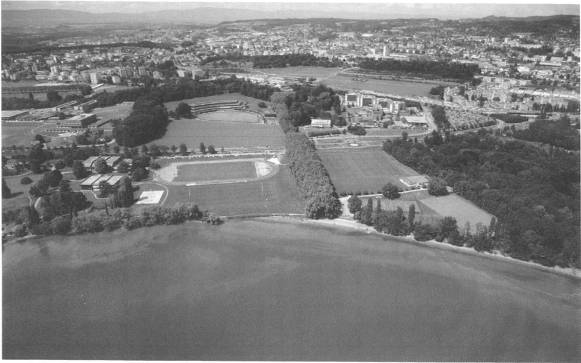
1 Vue aérienne du Centre sportif de Dorigny (photo Alain Herzog).
