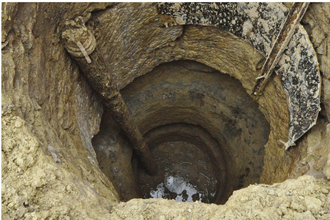
Fig. 4. Échallens – Place des Balances 1. Le système de pompage encore en place une fois le puits vidé (photo Archéotech SA, C. Laurent).
