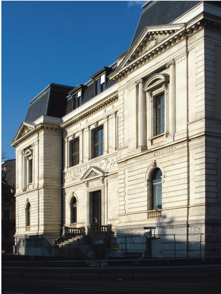
Vevey, le Musée Jenisch. Façade principale, état en 2012. Cliché de l'auteur.
