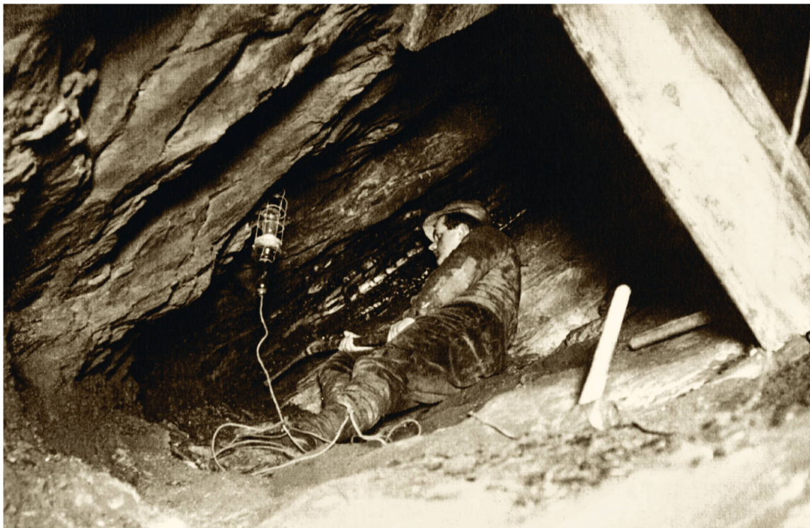
Exploitation du gisement et l'extrémité d'une galerie non encore étayée, mine dans la région d'Oron-La-Ville, vers 1918-1919.
