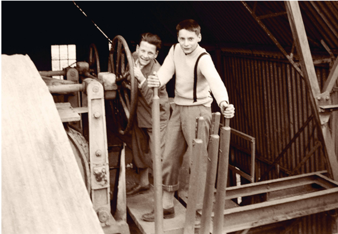
Le chantier de Cuarny restait ouvert aux enfants du village... Vers 1936.
