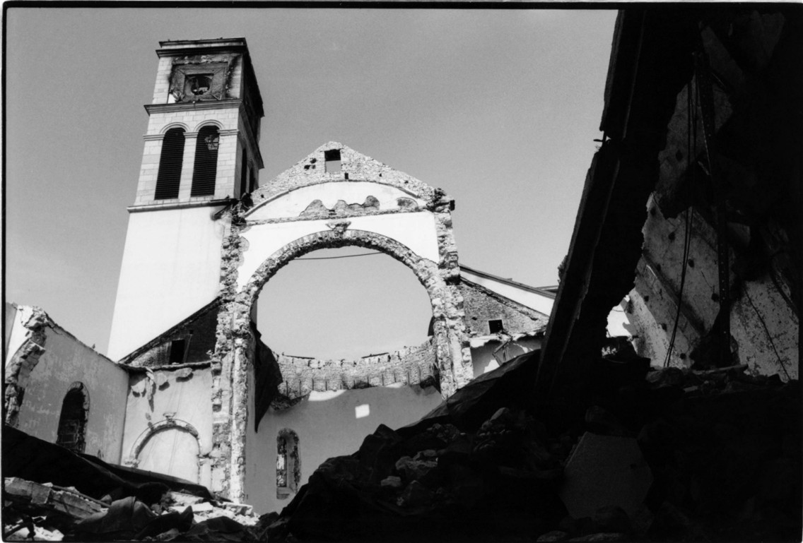
18. Hélène Tobler. Mostar, Bosnie-Herzégovine, avril 1993. Dans une guerre entre ethnies et religions différentes, les lieux sacrés deviennent des symboles à détruire. Ainsi, une église qui devait être imposante est réduite à son ossature.
