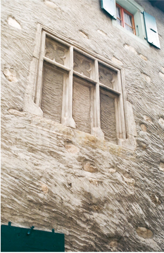
Riex, rue Davel, les remplages gothiques d'une ancienne fenêtre restent visibles sur la façade.
