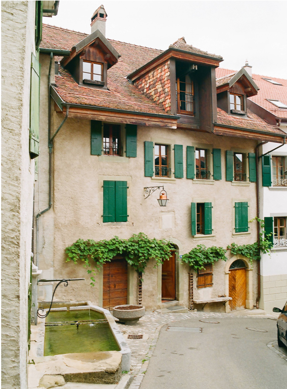
Sous-Riex, Au centre, l'entrée de l'habitation porte la date de 1835 avec les initiales du propriétaire François-Louis Palaz. Les portes des locaux viticoles sont aussi datées: celle du haut 1826, celle du bas 1838 avec une grappe et une serpette.
