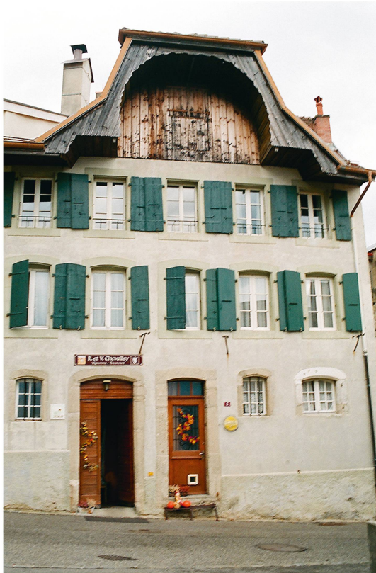
Rivaz, maison vigneronne cossue. Le large dôme servait à monter bois et ceps morts destinés au chauffage, directement de la rue au galetas.
