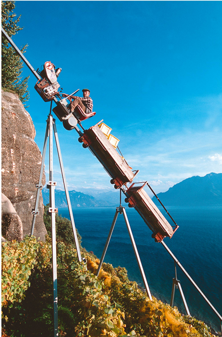
Premier monorail dans le Dézaley, dit monorail « Chaudet », construit en septembre 1976.
