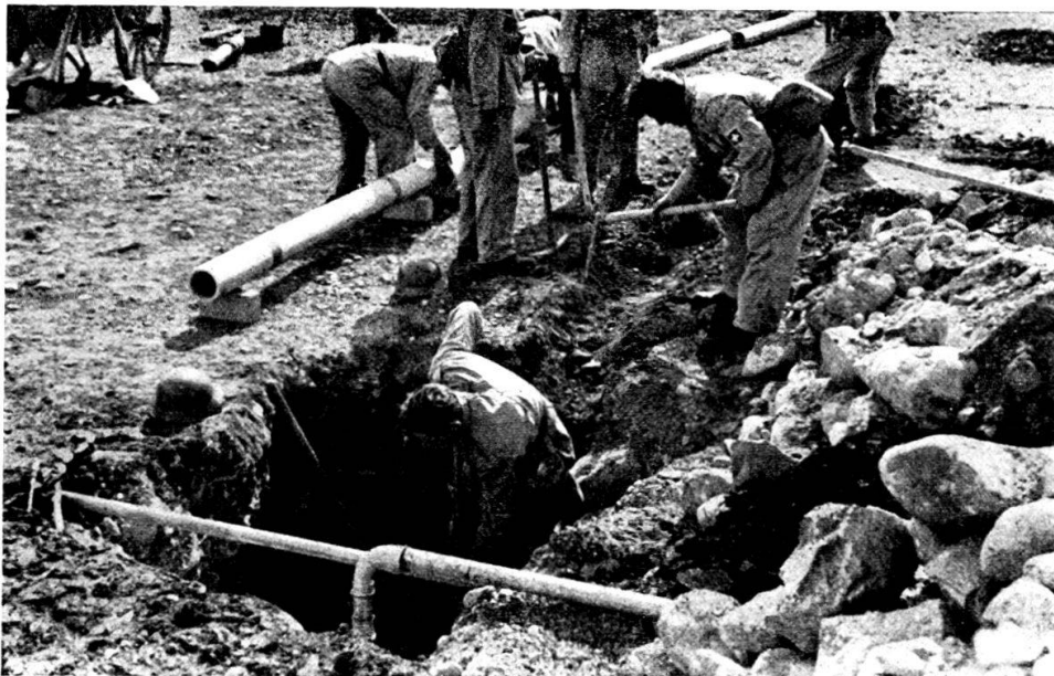
Servizio tecnico: riparazione di condotte distrutte.
