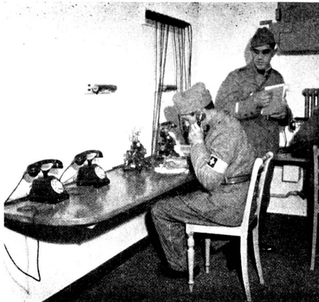
Centrale di allarme.
