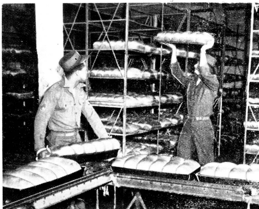
Uscita del pane dai forni e trasporto su nastri nel luogo di raffreddamento
