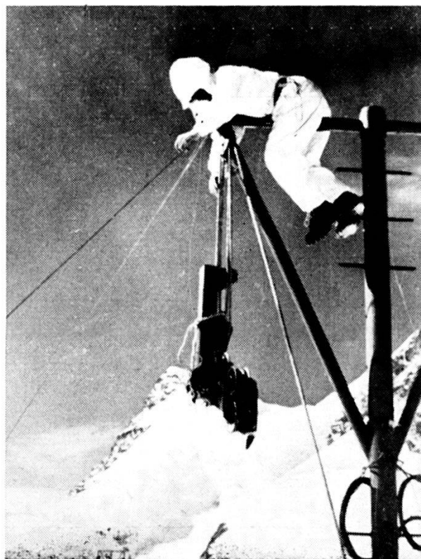
Costruzione di teleferiche in alta montagna.
