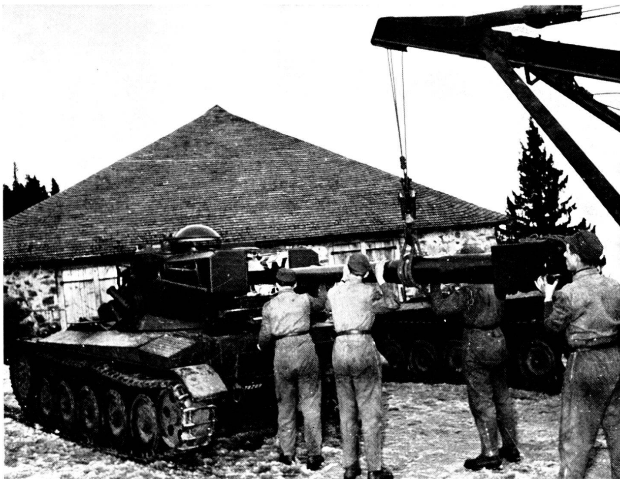
Meccanici di carri, sostituiscono il cannone di un carro leggero 51 (AMX)
