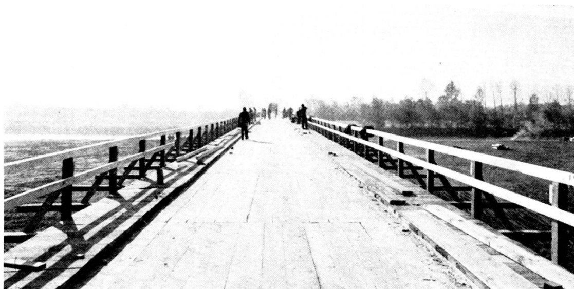
Il nuovo ponte ultimato
