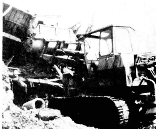
Sgombero di strade. Strade e passaggi sbarcati da macerie vengono sgomberati e riaperti al traffico.
