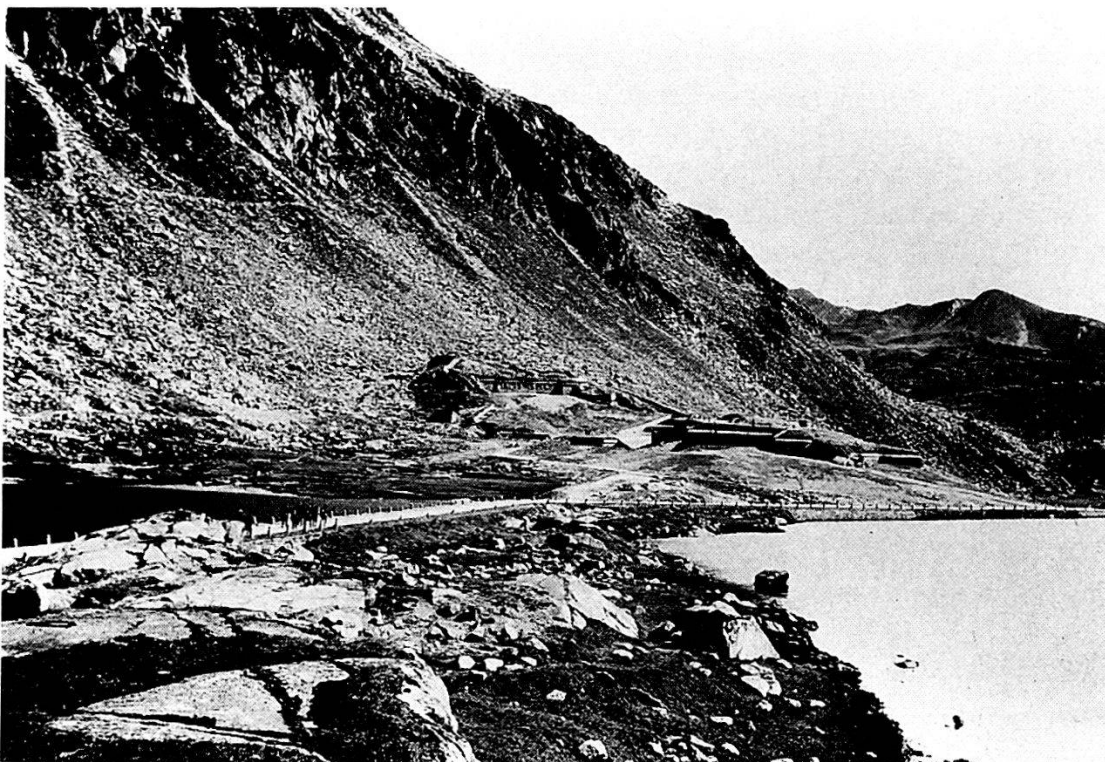
Forte Ospizio visto da nord.
