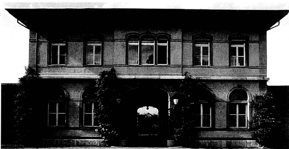
L'edificio amministrativo della ex-Regia dei cavalli integrato nel nuovo complesso.
