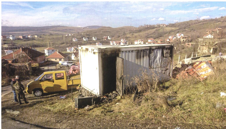
PC Mitrovica Nord vandalizzato
