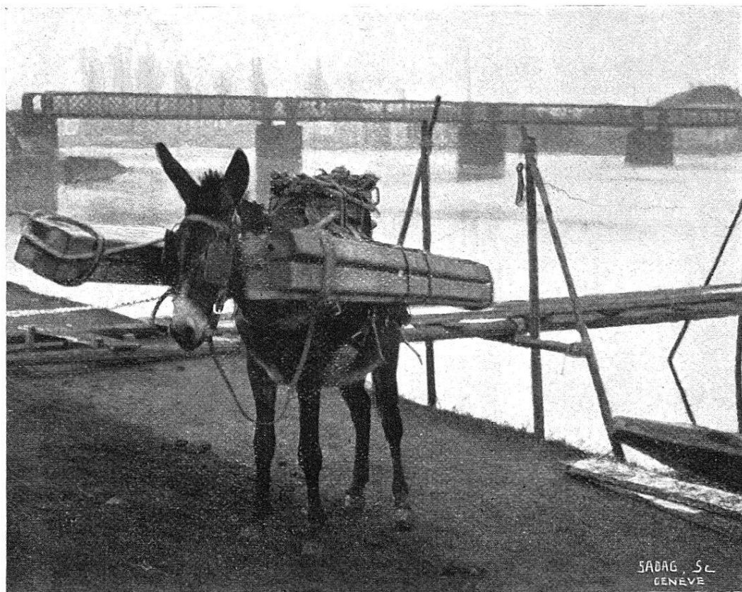
CHARGEMENT DU MATÉRIEL DE GUINDAGE. (Celui des poutrelles s'effectue de la même manière.)
