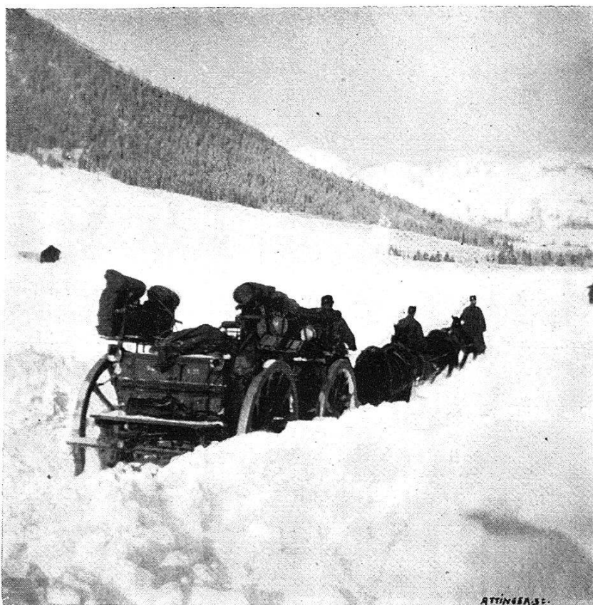
FIG. 6. — Etat de la route entre les Mosses et la Lécherette.
