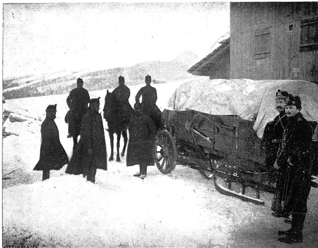
FIG. 10. — Fourgon de batterie, avec arrière-train sur luge.
