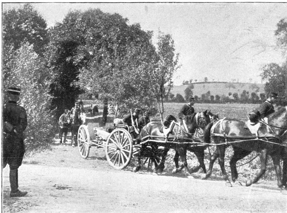
Batterie de 75 mm. quittant les Eteaux.
