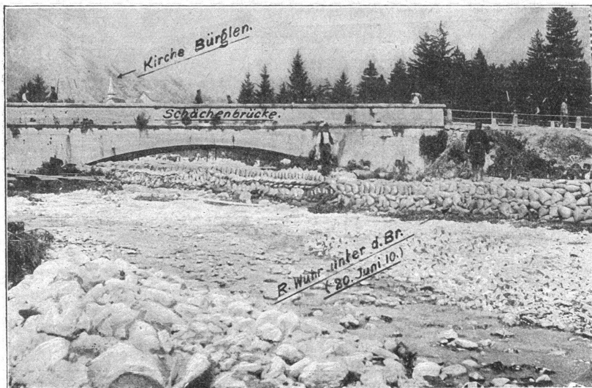
6. Altorf. Travaux de défense en aval du pont du Schächen.
