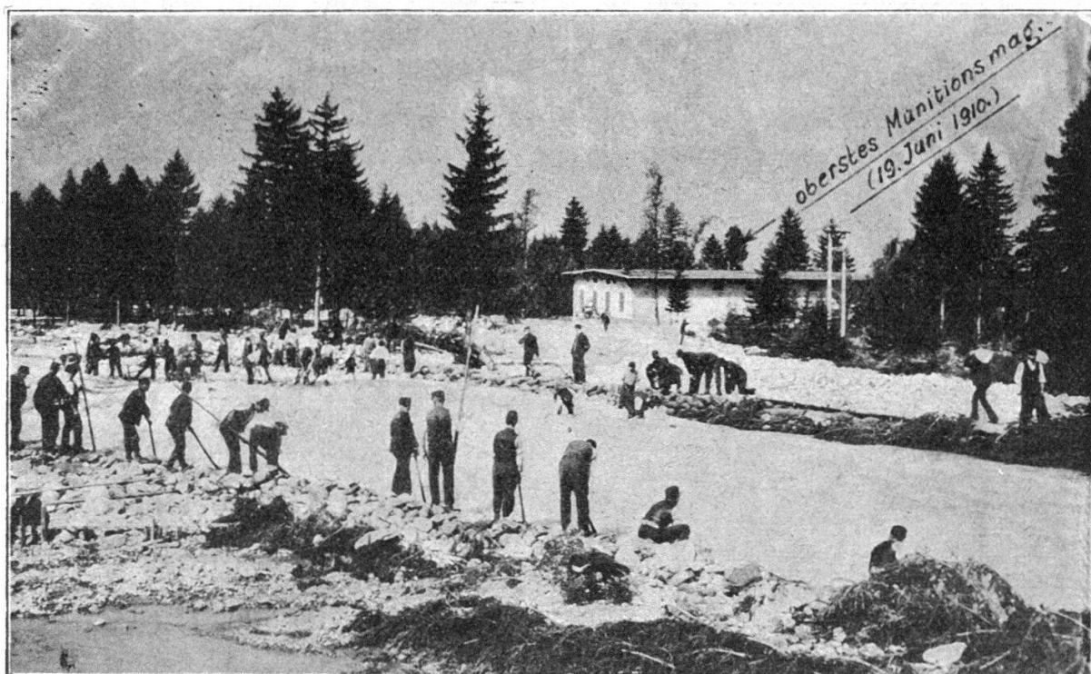
3. Altorf. Curage du nouveau lit du Schächen.
