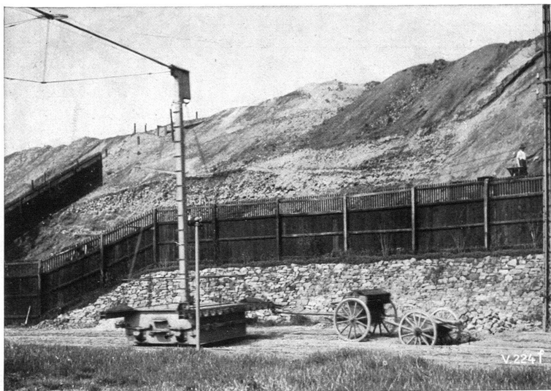
Fig. 16. — Caisson à munitions au passage d'une excavation à pentes raides sur la piste de roulage d'Essen.
