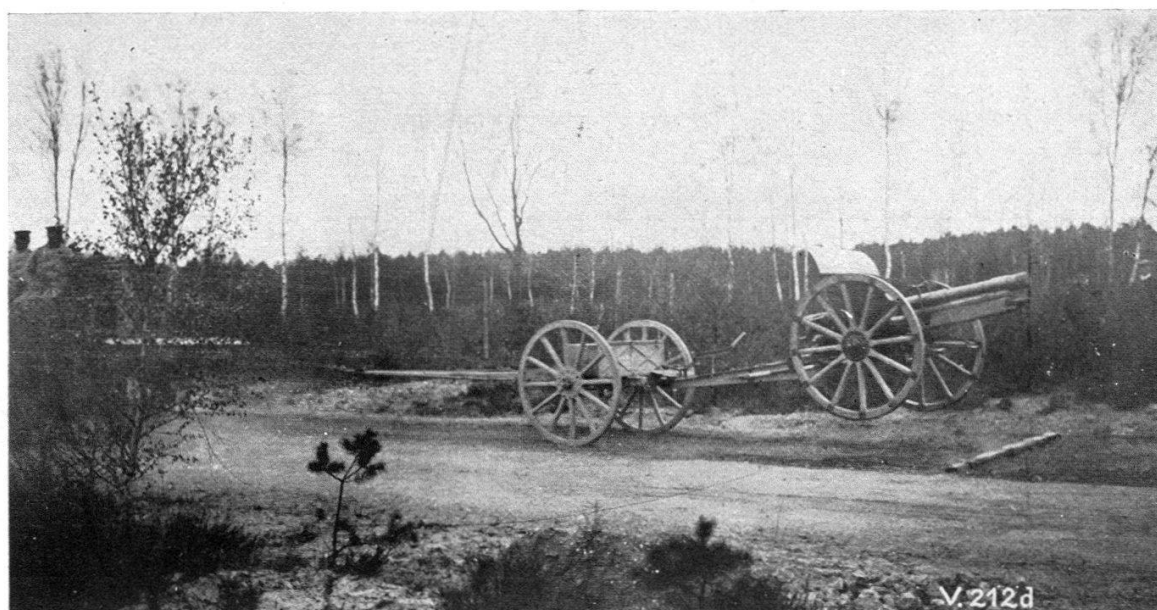
Fig. 10. — Canon de campagne de 7.5 cm. L/50, à recul sur l'affût, franchissant une poutre fixée en travers de la piste de roulage de Tangerhütte.
