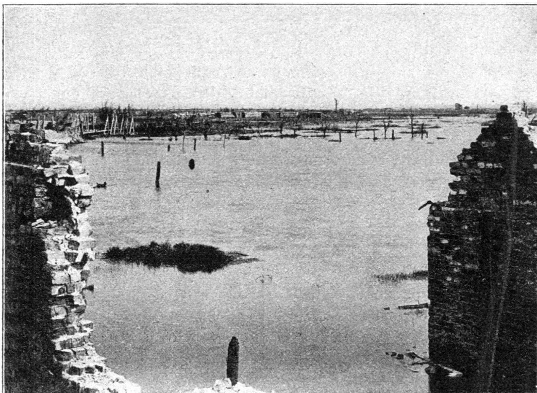
Première ligne vue d'une grand-garde dans l'inondation.
