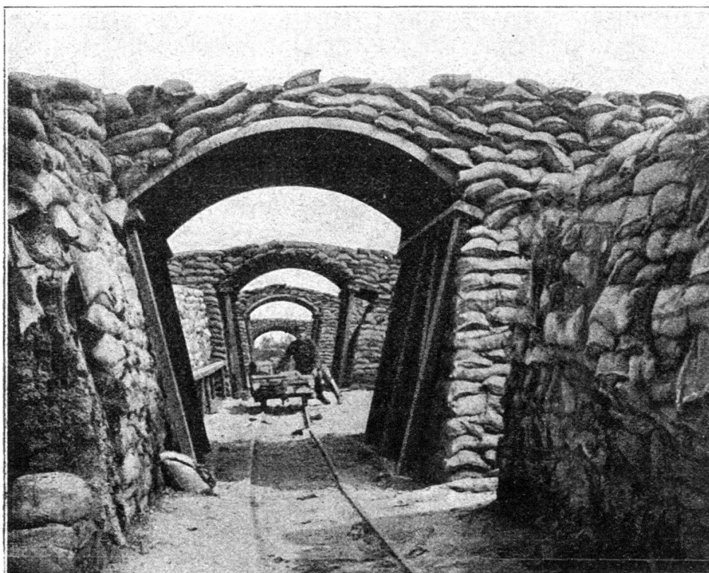
Type de boyau avec portiques couvrant contre le tir ennemi, et voie Decauville.
