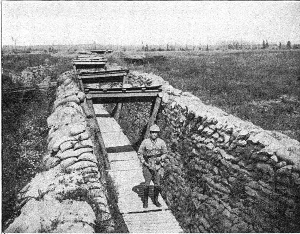
Boyau en sacs à terre, avec portiques et caillebotis.
