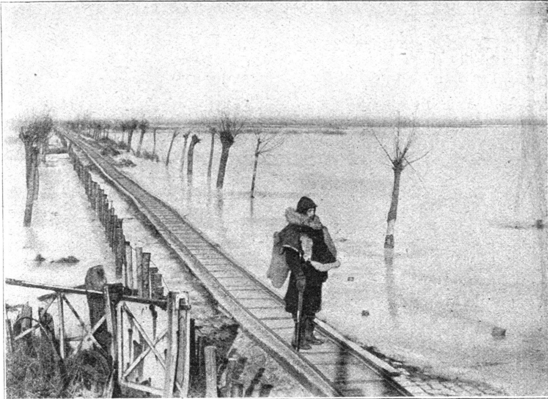
Route transformée en passerelle sur l'inondation. Une voie Decauville y est installée.
