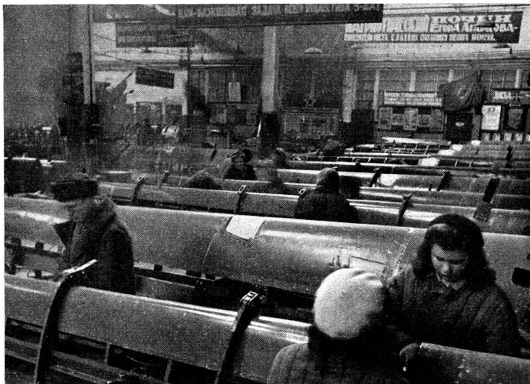
Des avions d'assaut « Iliouchine » au montage dans une usine.
