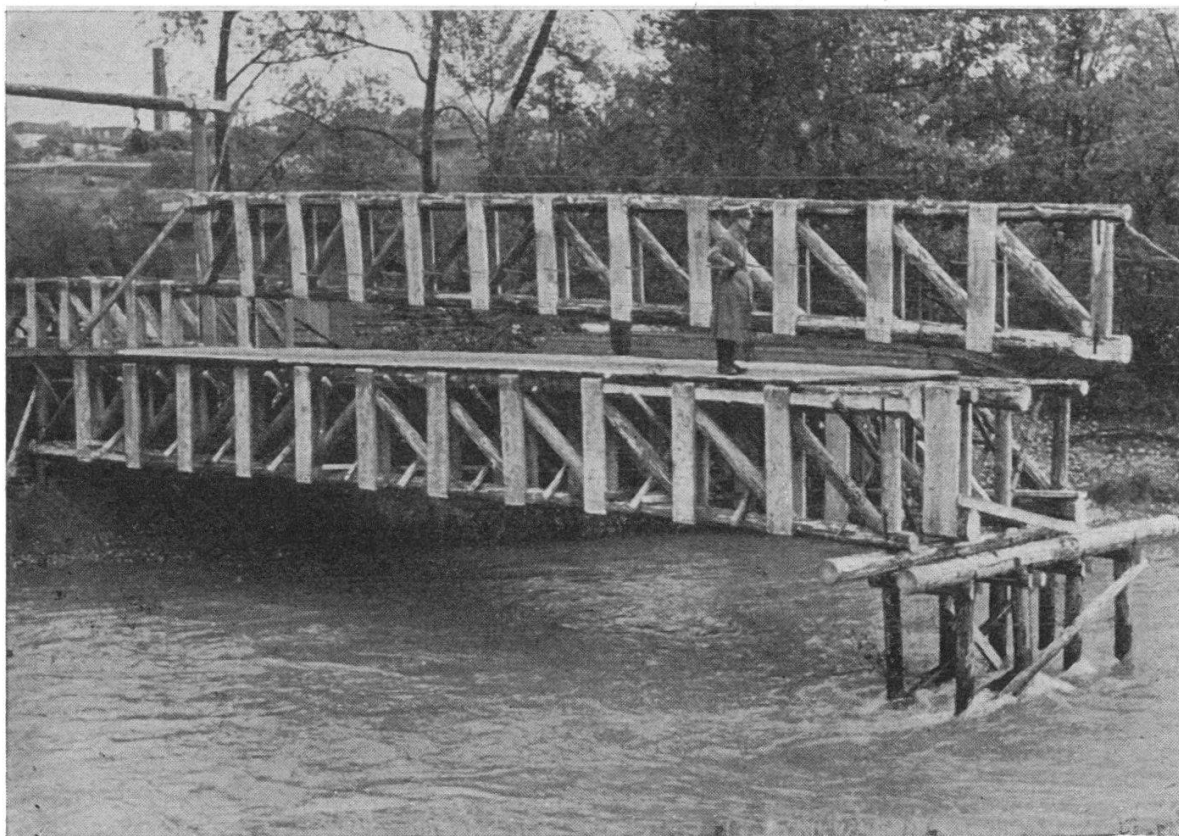
FIG. 2. — Mise en place d'une poutre à treillis en bois à l'aide d'un câble.
