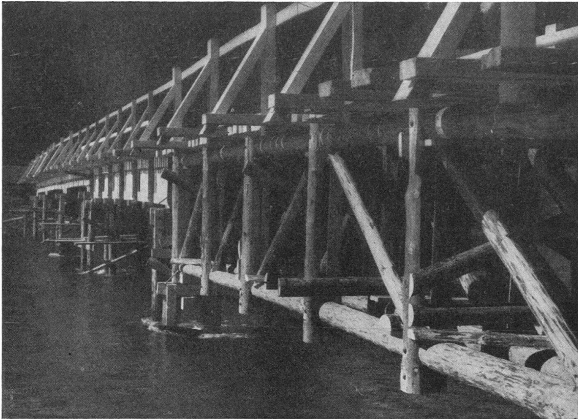
FIG. 1. — Pont de fortune en bois, construction d'essai. Première travée au premier plan : poutre à treillis ; seconde travée : poutre clouée ; les trois dernières travées : poutres jumelées.
