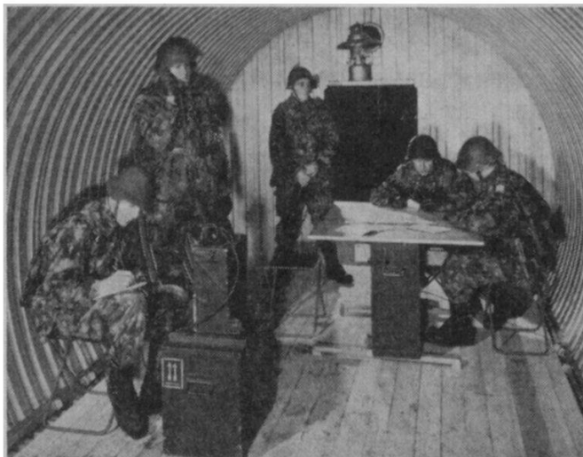
FIG. 1. Poste de commandement sous abri-tunnel.
