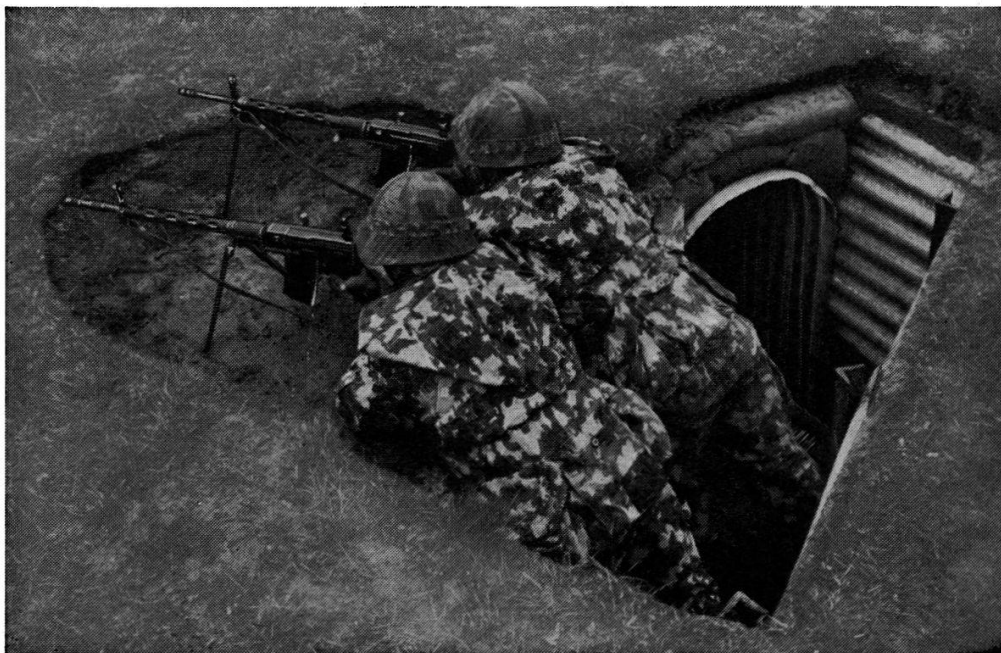
Fig. 3. — Trou de tirailleurs, pour deux hommes, avec niche.
