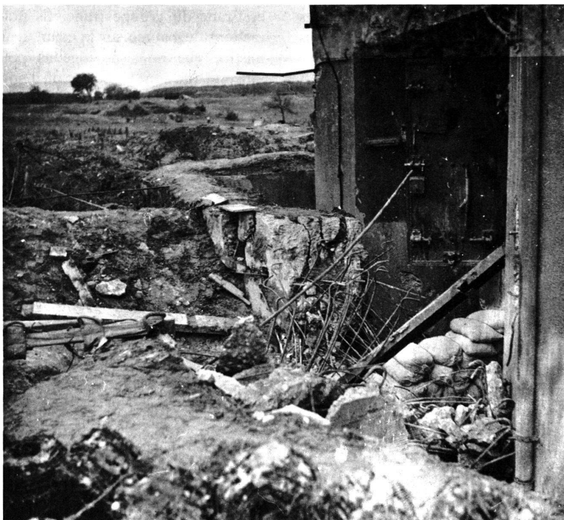
Le fossé arrière de la casemate.
