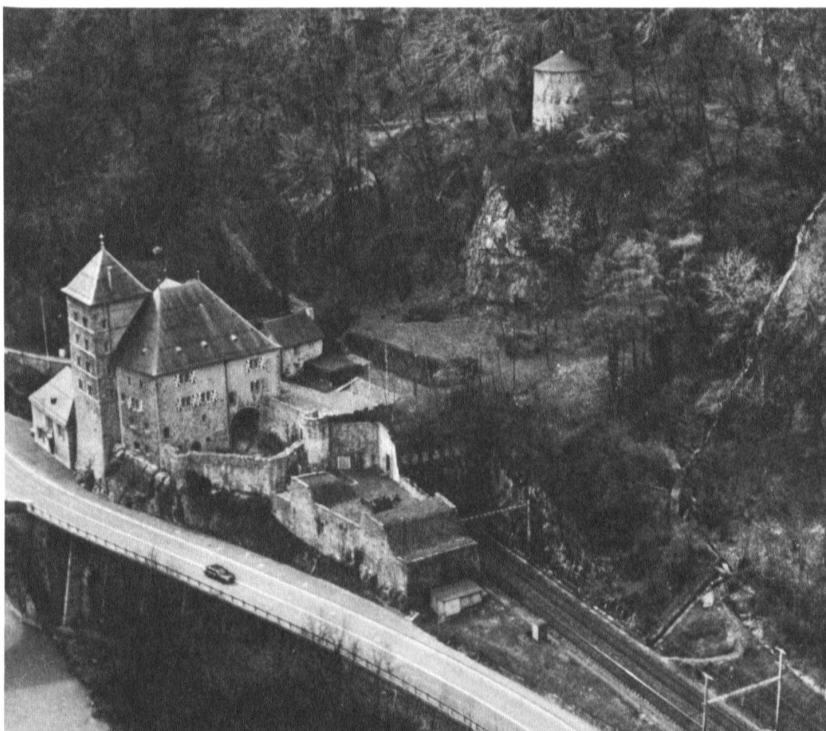
Le château de Saint-Maurice avec les bastions et la tour crénelée dite Tour Dufour Photo D. Weismann, archéologue cantonal vaudois.
