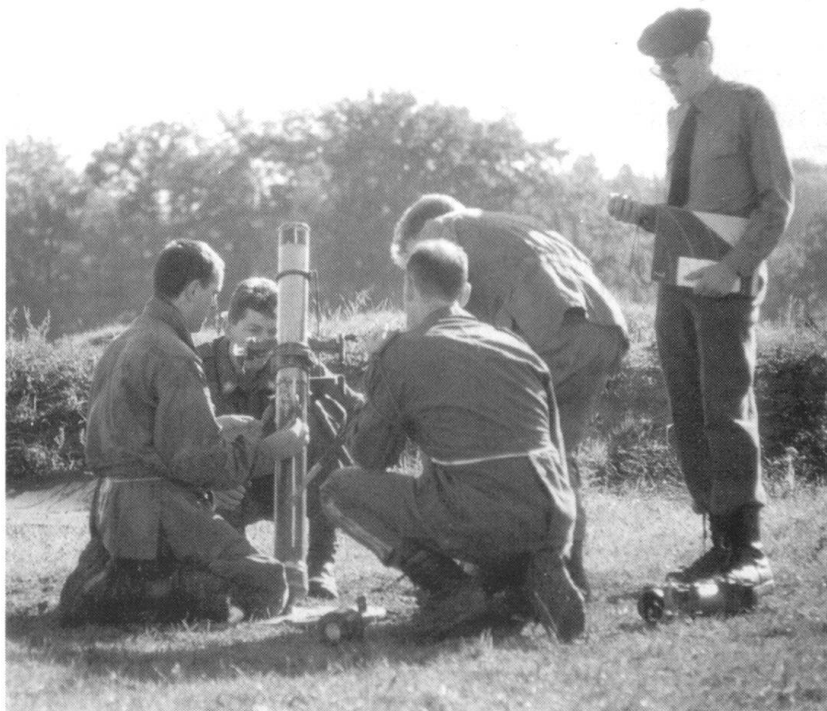
L'utilisation du «niveau de secours» laisse parfois perplexe!
