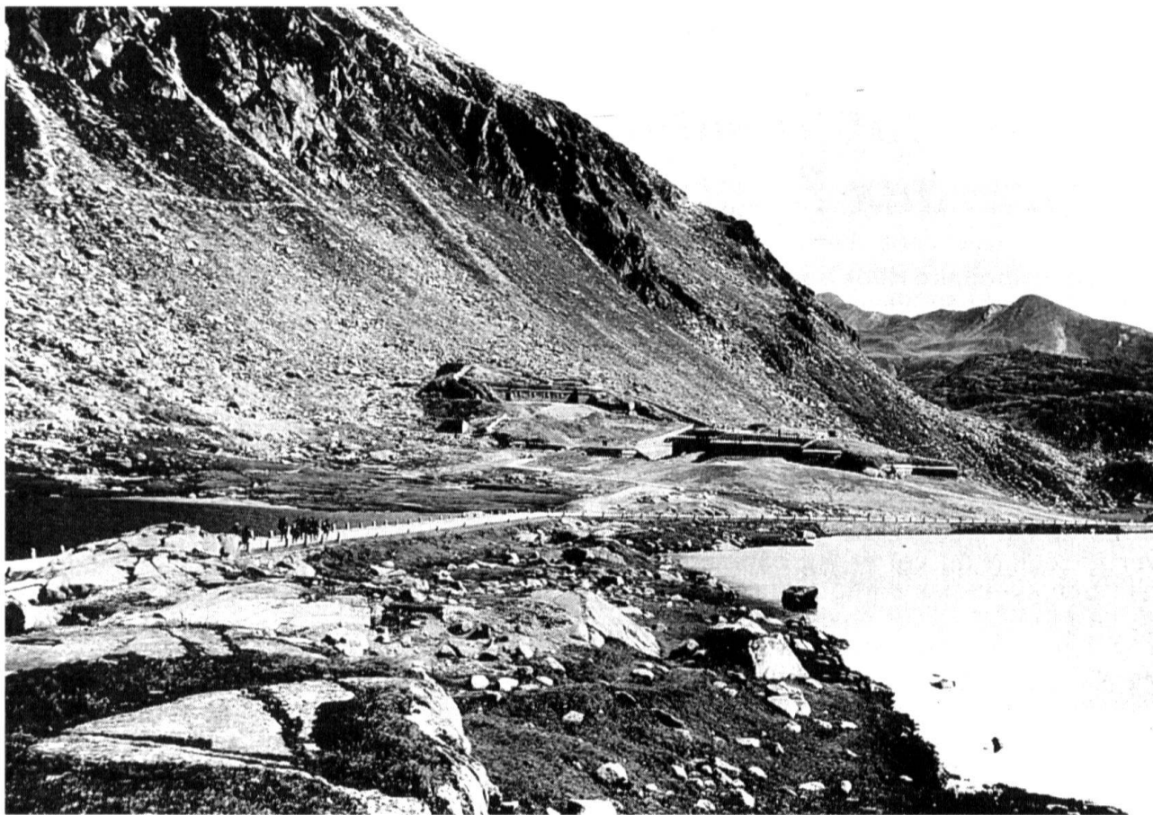
L'ouvrage de l'Hospice vu du Nord. (Bibliothèque centrale de Zurich).
