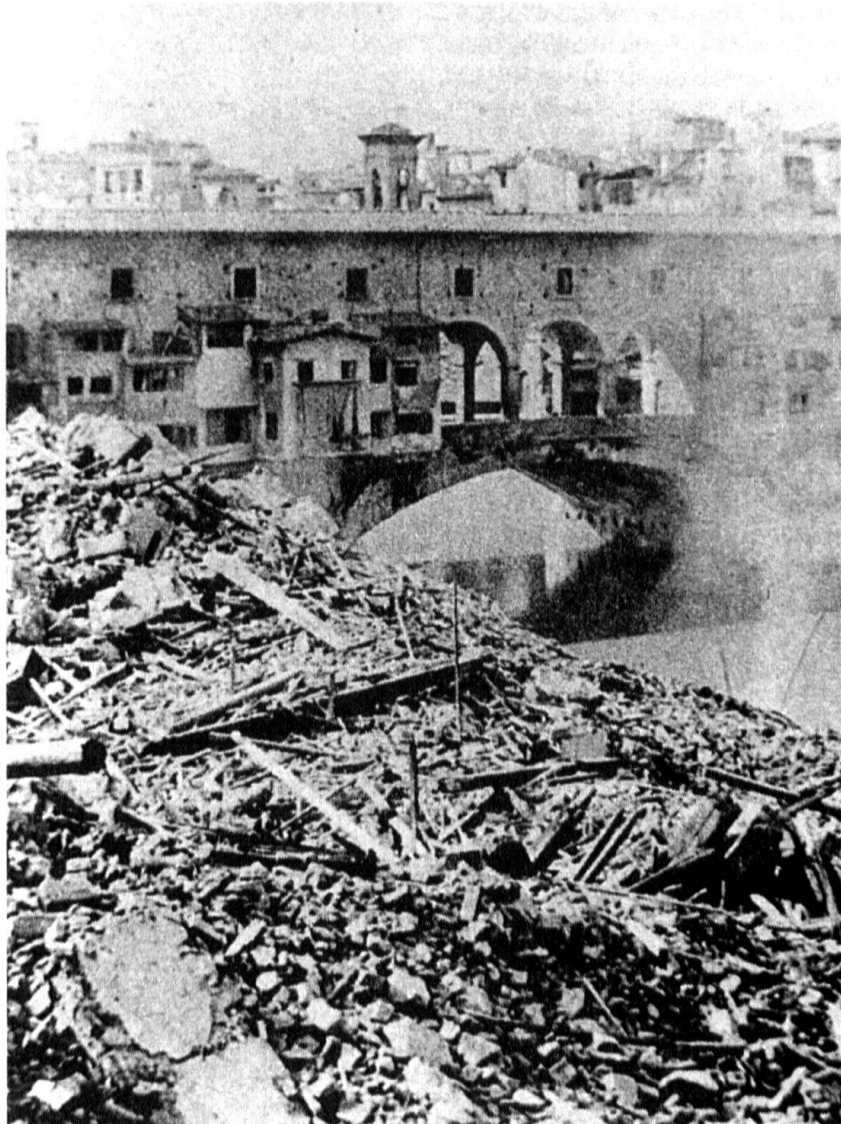
Ponte Vecchio 1944. Les gravats sont les ruines des immeubles de la via dei Bardi.
