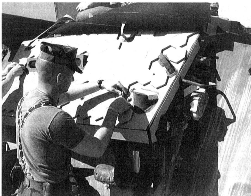
La pose de LAST Armor ne requiert qu'un peu de sens pratique et un outillage simple (Photo : LAST Armor).
