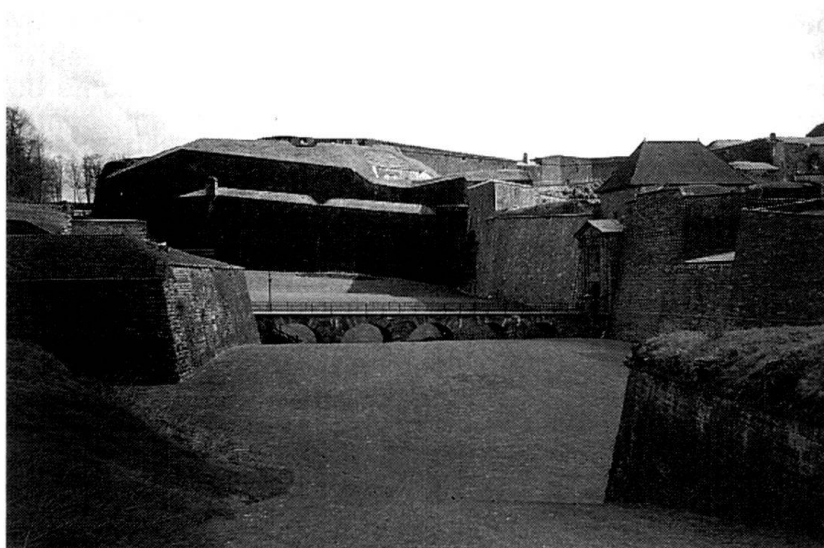
Entrée Ouest de la ville. (Photo : H. W.)
