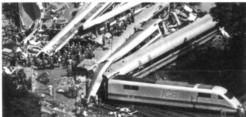
Accident ferroviaire d'un ICE en Allemagne (3.6.1998).
