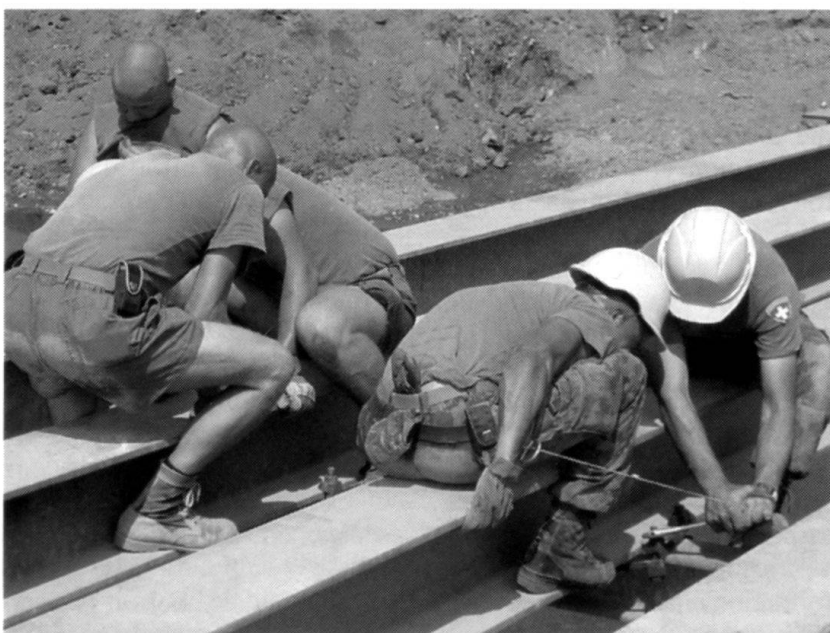
Des pionniers suisses travaillent sur le pont de Prestovo.
