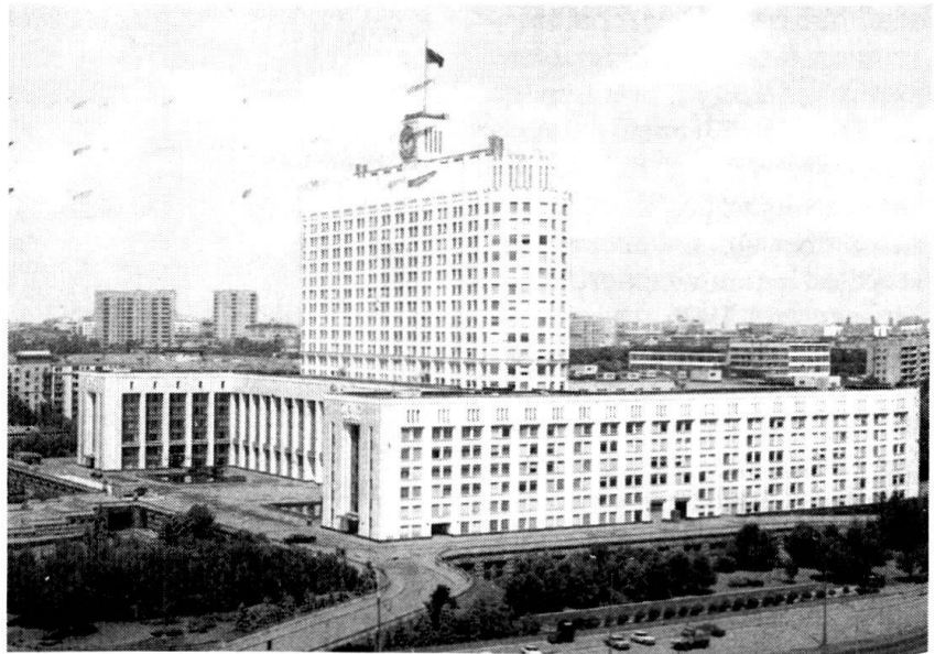
Moscou: la « Maison blanche », le bâtiment de la Douma.
