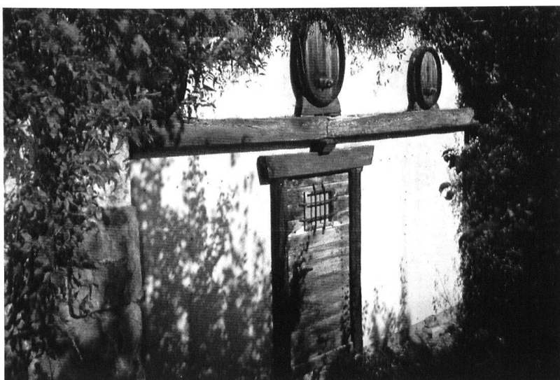
Camouflage en Valais d'un fortin armé d'un canon antichar de 9 cm. (Photo: M. L.)
