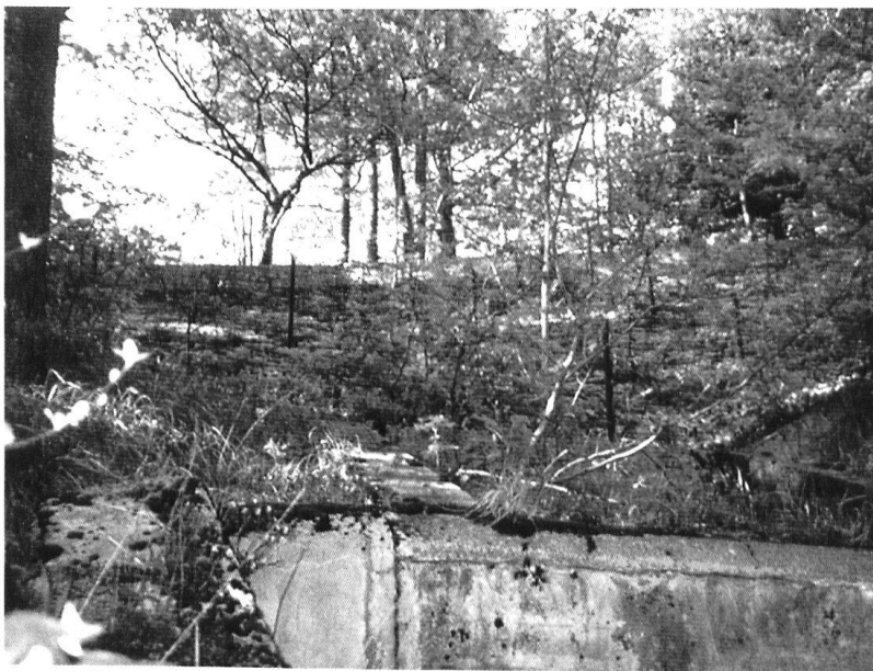
Ouvrage du Gy: la dalle qui recueille l'eau de pluie, pour l'équipage.
