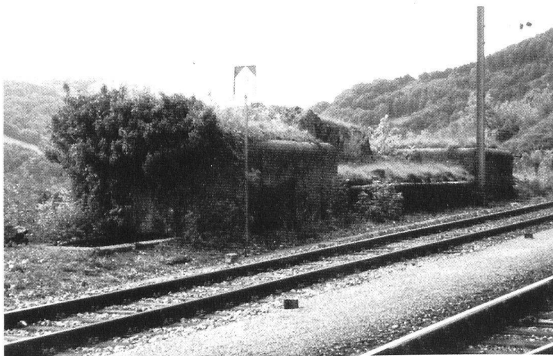
Un des ouvrages du secteur «Gare» à Saint-Ursanne (sud des voies).
